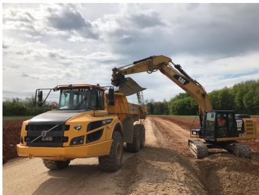
Les engins à l'œuvre pour construire la nouvelle voirie
